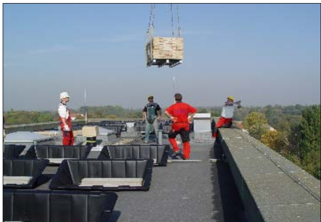
12.10.2006 Unmittelbar nach Aufstellung der Kunststoffwannen und dem Einbringen des Ballastes werden die Module mit Hilfe des Kranes auf das Dach transportiert und dort sofort vertragen und gesichert. (Bild links - Montage auf dem Dach der Matibi Grundschule)
