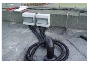
16. bis 20.10.2006 Die Modulmontage ist auf dem Dach der Prendener Str.15 ist abgeschlossen, hunderte Meter Kabel werden verlegt.
