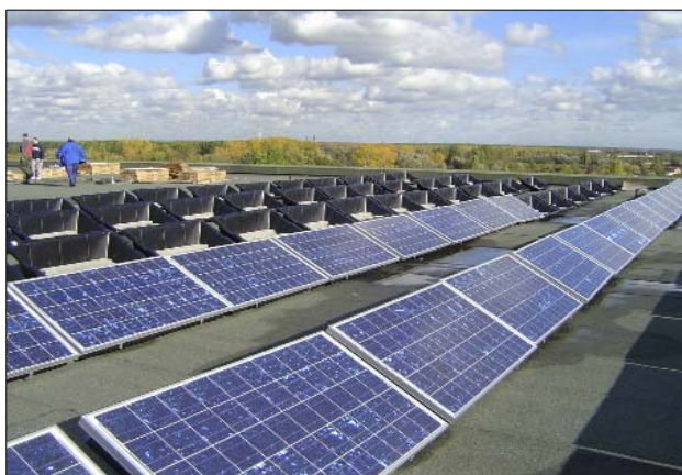
24.10.2006 Montage der Module auf dem Turnhallendach.
