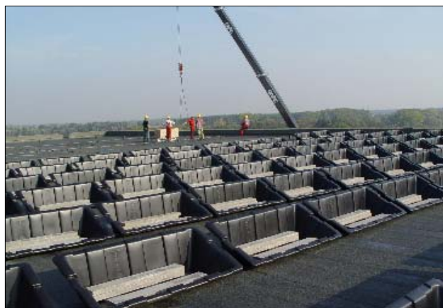
12.10.2006 Kunststoffwannen, speziell entwickelt für die Flachdachmontage, werden auf dem Dach nach entsprechenden Planvorgaben verteilt. Parallel dazu erfolgt sofort das Einbringen des Ballastes in die Kunststoffwannen. (Bild links - Montage auf dem Turnhallendach)
