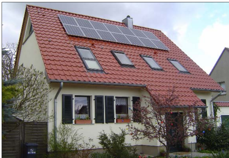
Klein aber Fein, die Präsentationsanlage der p&I photovoltaik GbR.
