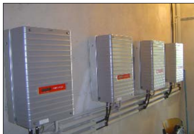
11.08.2005 Blick auf die 4 Stck Wechselrichter vom Typ Sunways NT 6000 während der Montage (Bild links) und nach Fertigstellung (Bild unten).
