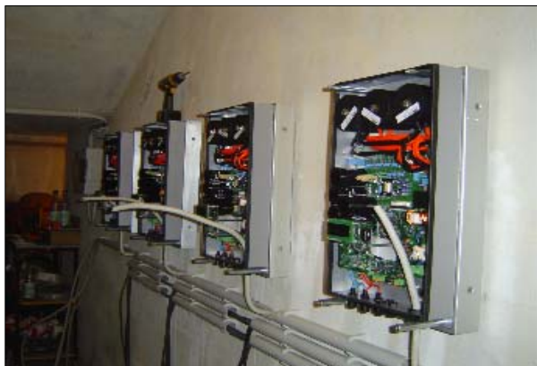
11.08.2005 Blick auf die 4 Stck Wechselrichter vom Typ Sunways NT 6000 während der Montage (Bild links) und nach Fertigstellung (Bild unten).
