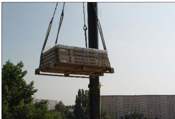
08.09.2005 Transport der Module mittels Kran auf das Dach am gleichen Tag (13.00 Uhr).
