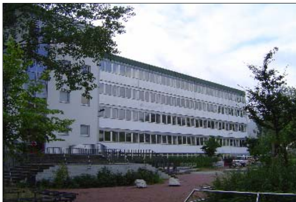
Schulgebäude Werneuchner Straße 15 in Berlin-Lichtenberg
